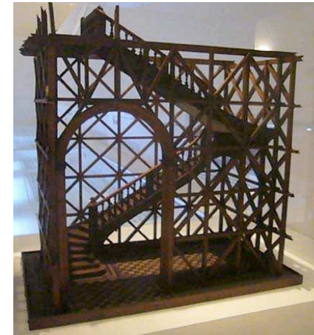
erdbebensichere Holzstruktur "gaiola pombalina"
